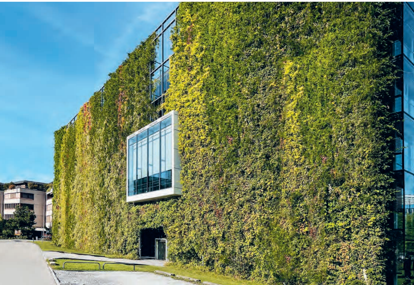
Vom Boden gegen den Himmel – Fassadenbegrünungen tragen zu einem besseren Mikroklima bei (Bild: Werner Erni)
