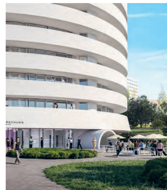
Neubau Universitäts-Kinderspital Zürich, Gebäude für Labor, Lehre und Forschung (Bild: Kinderspital Zürich)
