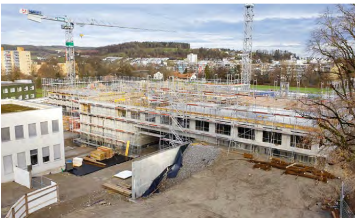
Links: Aufbau der Kranen, Juli 2020. Rechts: Grundsteinlegung und Versenkung der Zeitkapsel, 26. August 2020. Unten: Baustand 22. Oktober 2020.
