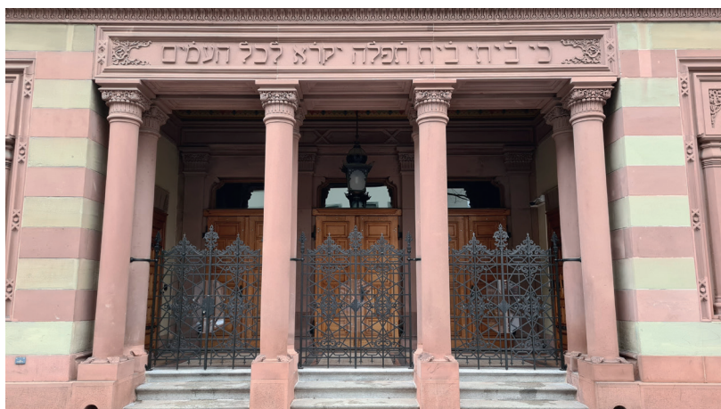
renovierter Eingangsbereich Synagoge Löwenstrasse
