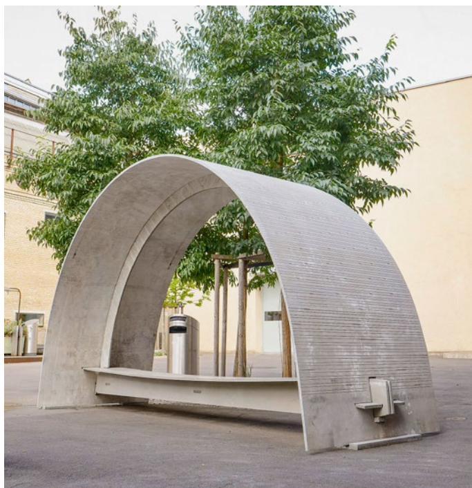
↑ Die Bogenbank aus CPC-Carbonbetonplatten auf dem Lagerplatz in Winterthur
