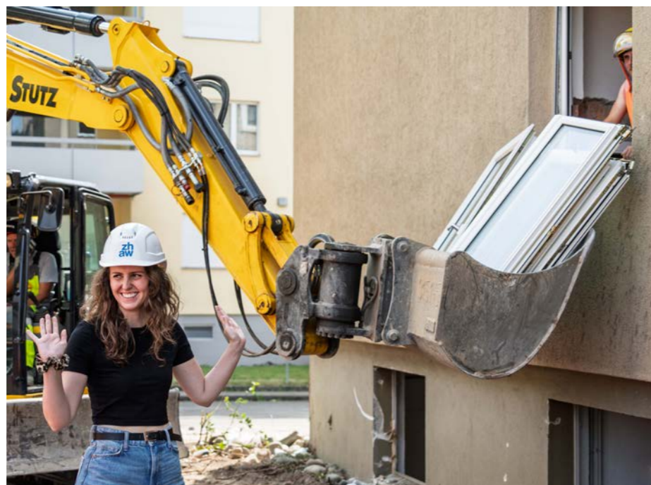
Bei einem Abbruchgebäude in Winterthur wurde das Glas sämtlicher Fenster vom Rahmen getrennt und für die Wiederaufbereitung gesammelt.
