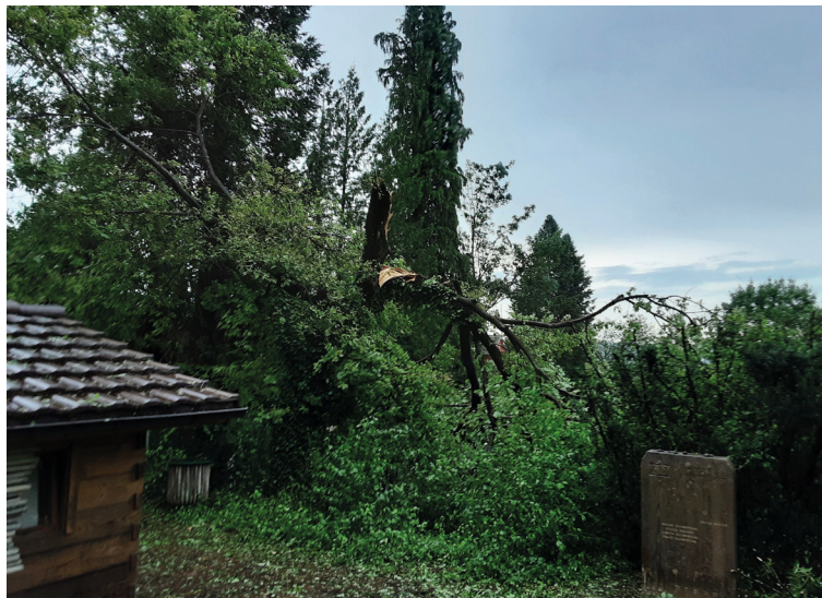
Sturmschaden auf dem JLG Friedhof.
