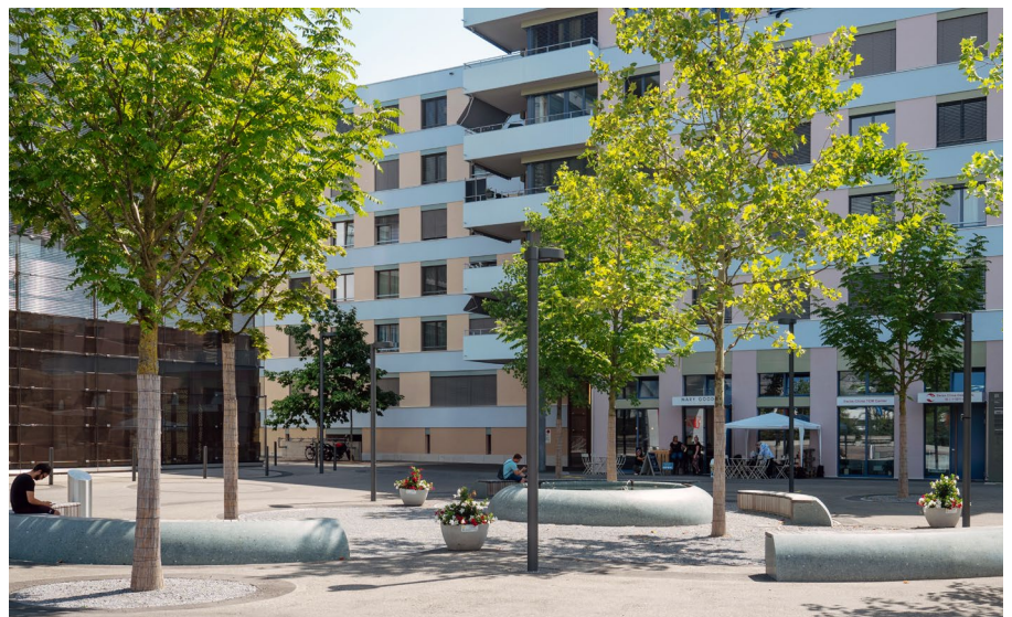
Abb. 3: Qualitativ hochwertige und öffentlich zugängliche Aussenräume steigern die Akzeptanz für Neubauten. Im Bild: Glattgarten, Wallisellen.
