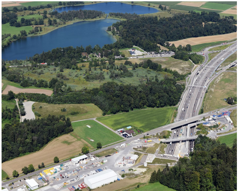
Abb. 22: Vielfältige Nutzungen sind in der Landschaft unterzubringen. Im Bild der Katzensee und die temporäre Installationsfläche der dritten Röhre des Gubristunnels.
