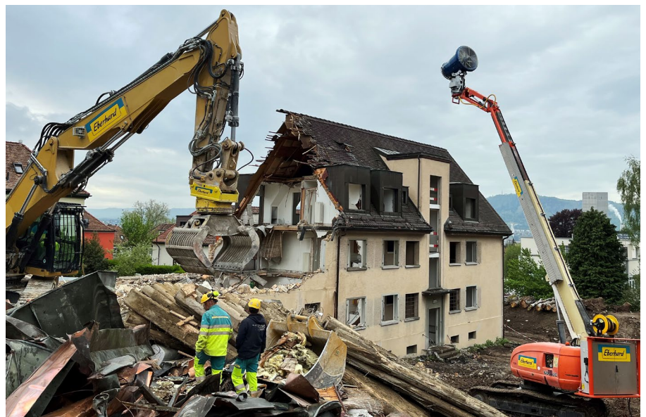
Abb. 2: Die Siedlungsentwicklung nach innen führt vermehrt zu Abbrüchen, die einer Neubautätigkeit vorausgehen.
