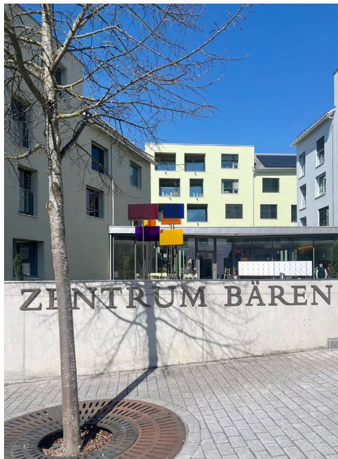
Abb. 16: Zentrum Bären in Nürens Dorf: Die Liegenschaft wurde von der Gemeinde erworben und zu einem Zentrum ausgebaut. Es bietet genossenschaftliche und preisgünstige Alters- und Pflegewohnungen, Gemeinschaftsräume, eine Arztpraxis, ein Restaurant und weitere Angebote.
